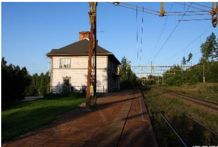
Figur 62: Den gamla plattformen framför stationshuset byggs om till en mellanhög plattform. (jvgfoto.se)
