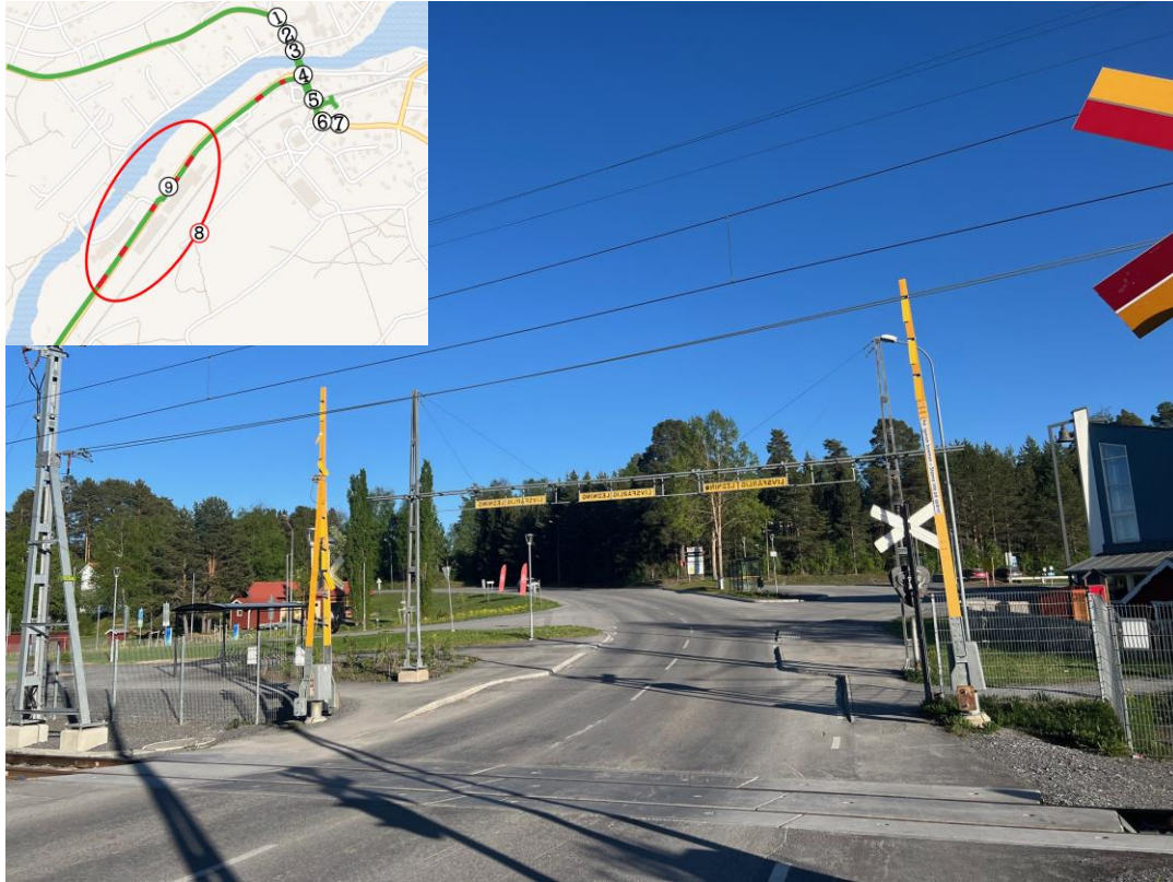
Figur 3-9 Vy över järnvägspassagen söderut med gångväg till tågstationen till vänster och busshållplatsen ICA Nälden till högst upp till höger i bild. Gångpassagen mellan buss och tåg syns sommartid men inte på vintern. Trottoaren närmast järnvägen är smal.
