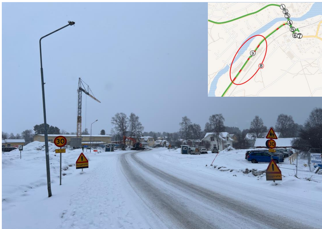
Figur 3-2 Brovägen, vid Nälldensskolan, fotat norrifrån.
